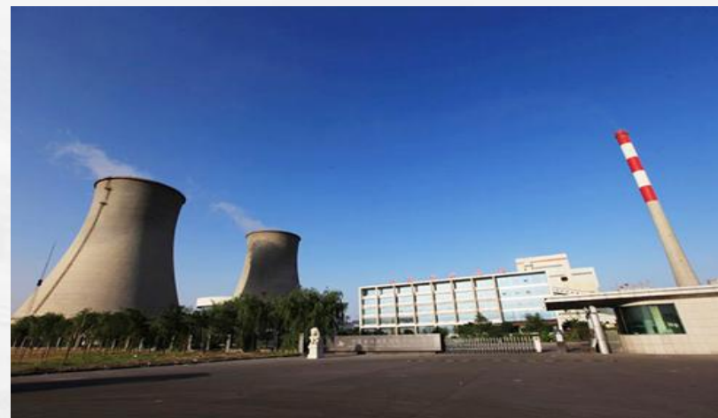
宁电投西夏热电厂2*350MW
